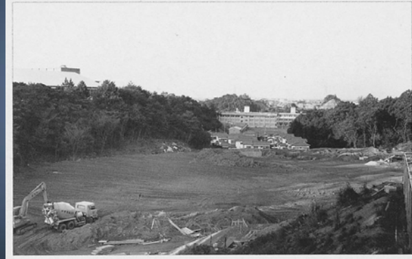
第2グラウンド建設のための工事（土地がずいぶん開けてきました）
