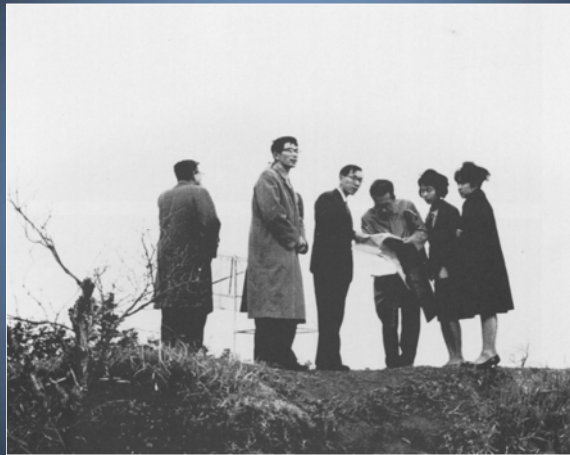
校舎建設予定地にて打ち合わせ
