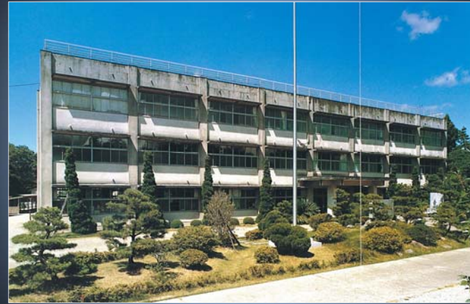
第20期生の卒業アルバムより — 旧管理棟 風格が出てきたというより、ずいぶん古くなりました。
