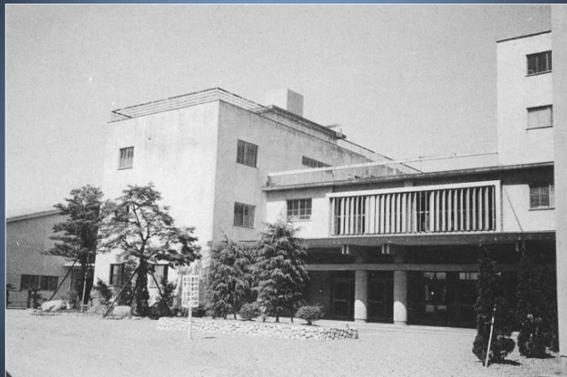
第8期生の卒業アルバムより — 当時の生徒玄関（管理棟と1号校舎の間）
