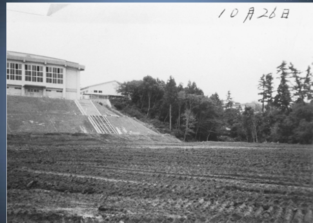
第2グラウンド建設のための工事(現在の風景に近づいてきました)
