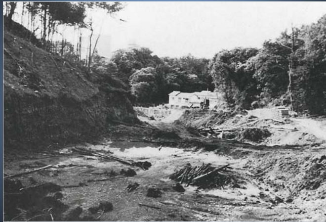
第2グラウンド建設のための工事
