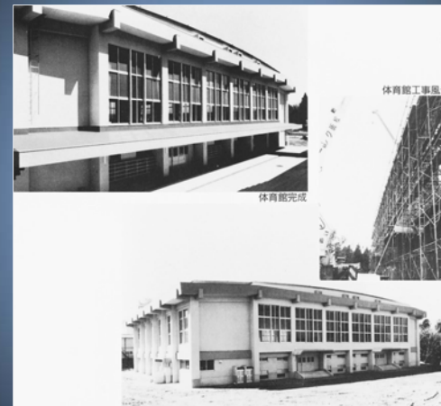
第2体育館建設の様子と完成直後の写真
