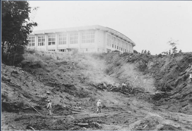
第2グラウンド建設のための工事(大変、大掛かりな土地の開拓工事です)
