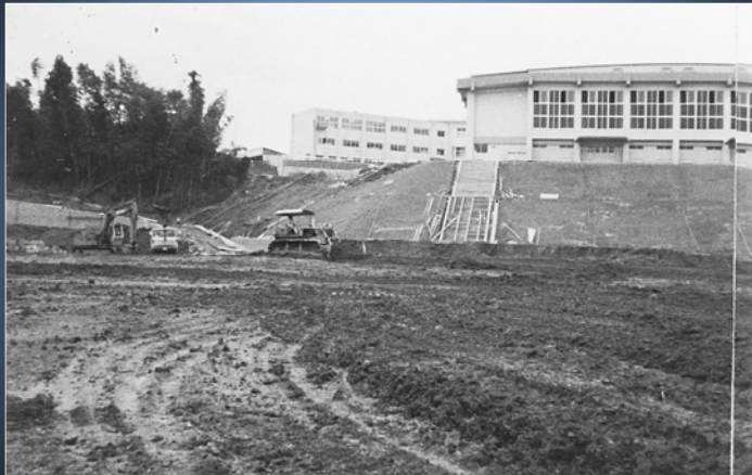
第2グラウンドの完成に近づいてきました
